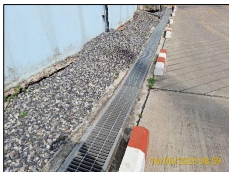
รูปที่ 2.2-7 รางรวบรวมน้ำฝนที่อาจปนเปื้อนน้ำมัน
