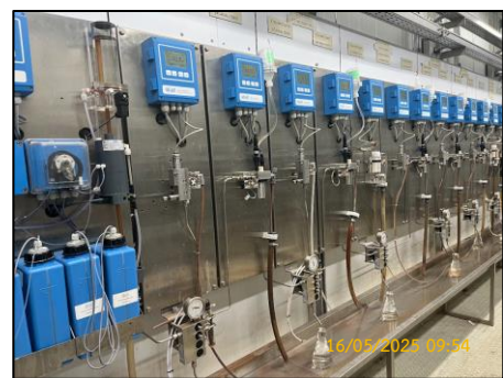
รูปที่ 2.2-12 อุปกรณ์ควบคุมลักษณะสมบัติของน้ำที่หมุนเวียนในระบบหล่อเย็น
