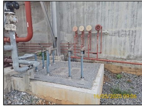
รูปที่ 2.2-10 ระบบบำบัดน้ำเสียสำเร็จรูป
