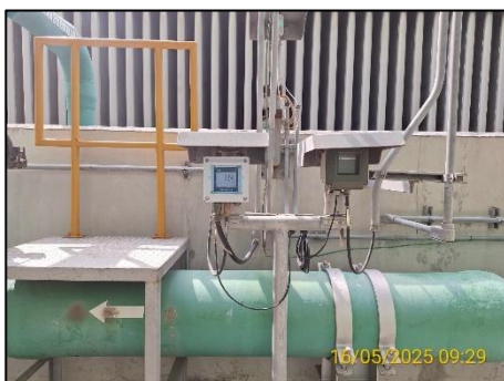
รูปที่ 2.2-13 ระบบตรวจวัดคุณภาพน้ำแบบอัตโนมัติ (Online monitoring)
