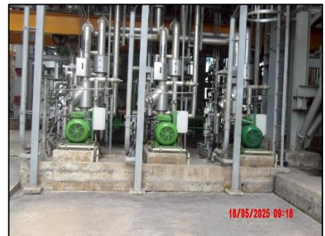
รูปที่ 2.2-35 ปั๊มน้ำเติมหม้อไอน้ำสำรอง
