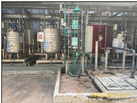
รูปที่ 2.2-32 อ่างล้างตา/ฝักบัวฉุกเฉิน
