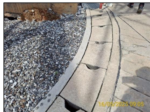
รูปที่ 2.2-6 รางรวบรวมน้ำฝนพื้นที่ทั่วไป
